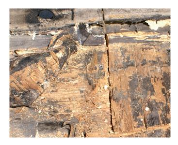
Abb. 3: **Schadensbild** Sekundärkondensat durch Restfeuchtverlagerung
