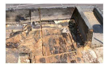
Abb. 1: **Schadensbild**Die Holzplatte verfault durch permanente Durchfeuchtung.
